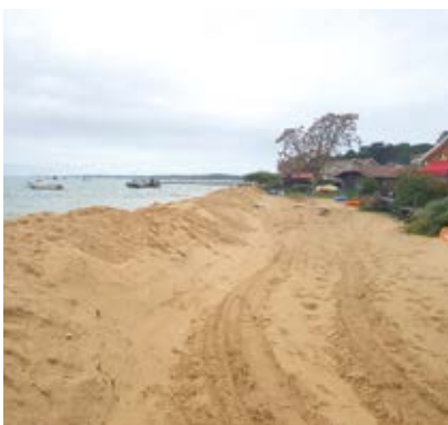
Construction d'un batardeau. Il s'agit d'un barrage réalisé avec le sable pour retenir l'eau de manière provisoire.
