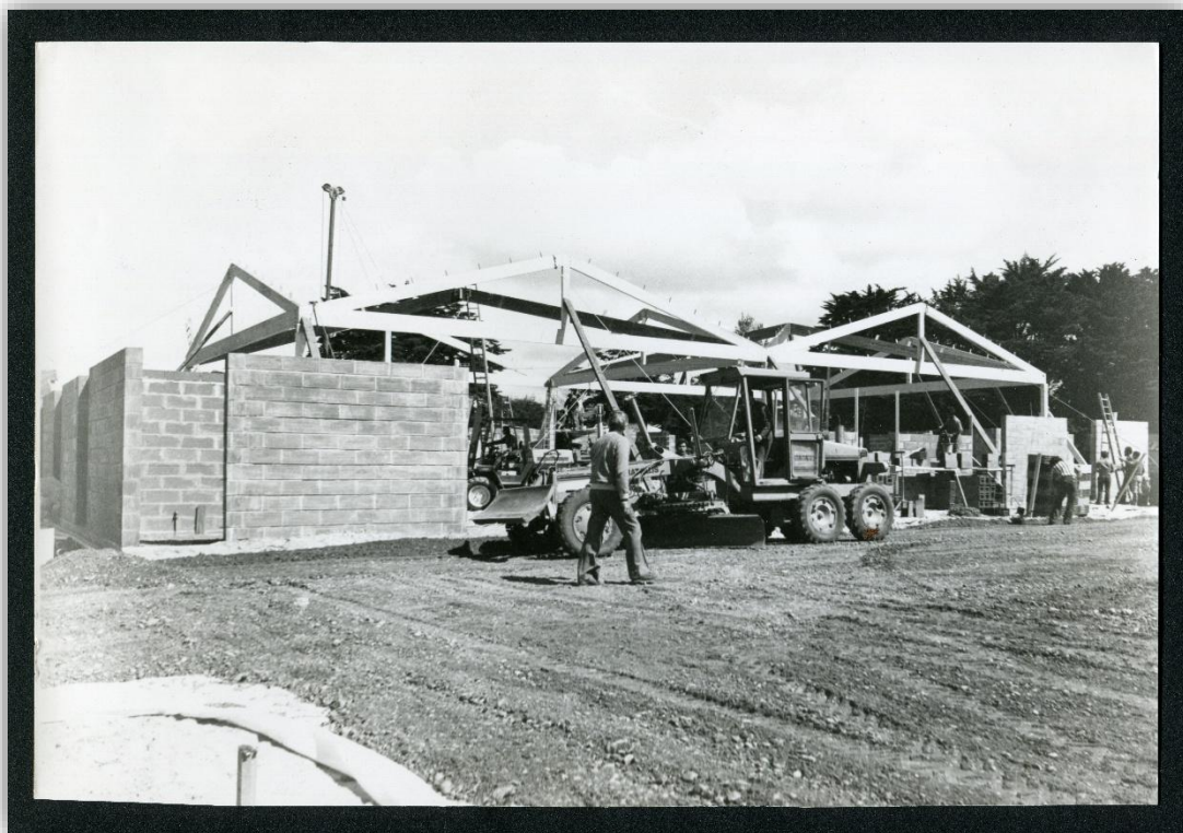
Le nouveau marché couvert du Cap Ferret en cours de construction, mai 1979 (photo. Annie Peyras, fonds photographique de la mairie, Archives municipales de Lège-Cap Ferret)
