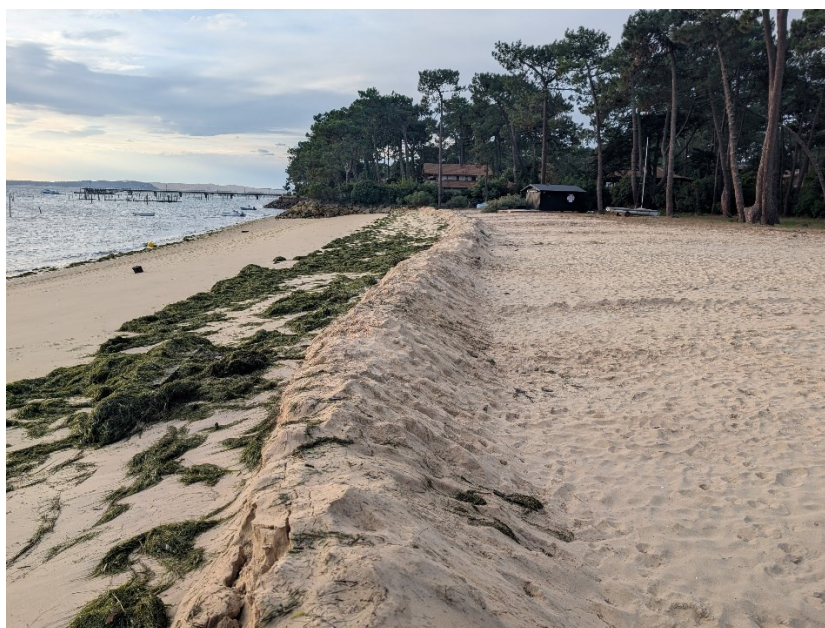
Figure 1-30 Merlon ayant résisté à la précédente marée haute sur la plage des Américains
