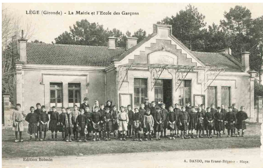
La mairie et l'école des garçons de Lège.
