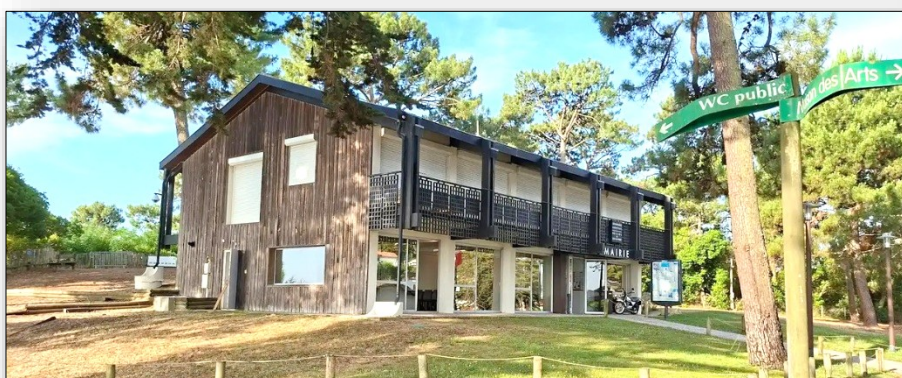
Mairie annexe du Canon à Lège Cap Ferret au bord du Bassin d'Arcachon
